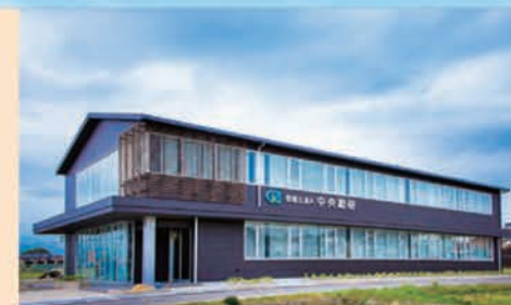
平成26年11月1日に移転オープンした新社屋。
